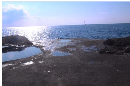
Slika 8: Betonirana i nivelirana stjenovita obala-šetalište i kupalište "Lungomare"-grad Pula-Pola
